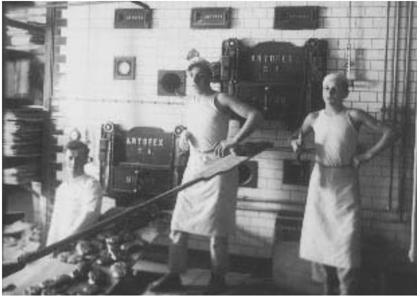
Die Backstube von Karl Mair in den 30er Jahren. Der Bau der Gampfenstraße ab 1936 hatte unter anderem eine spürbare Steigerung der Nachfrage nach Brot zur Folge.
