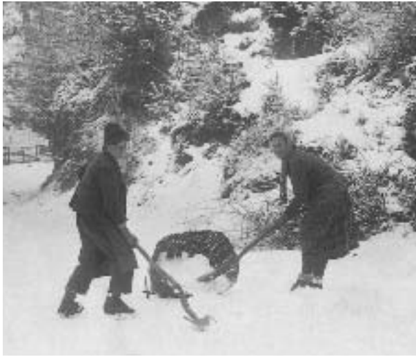
Zur Technik des Holztransportes: Frieda und Hermann Windegger füllen einen Korb mit Schnee und bedecken damit einen Abschnitt der Bergaufstrecke vom Prissianer Bach zur Zwingenburg, damit den Pferden das Ziehen der Stämme leichter fällt.
