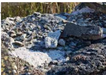
Fehlende Abdeckplatten fördern die Erosion der Mauer
