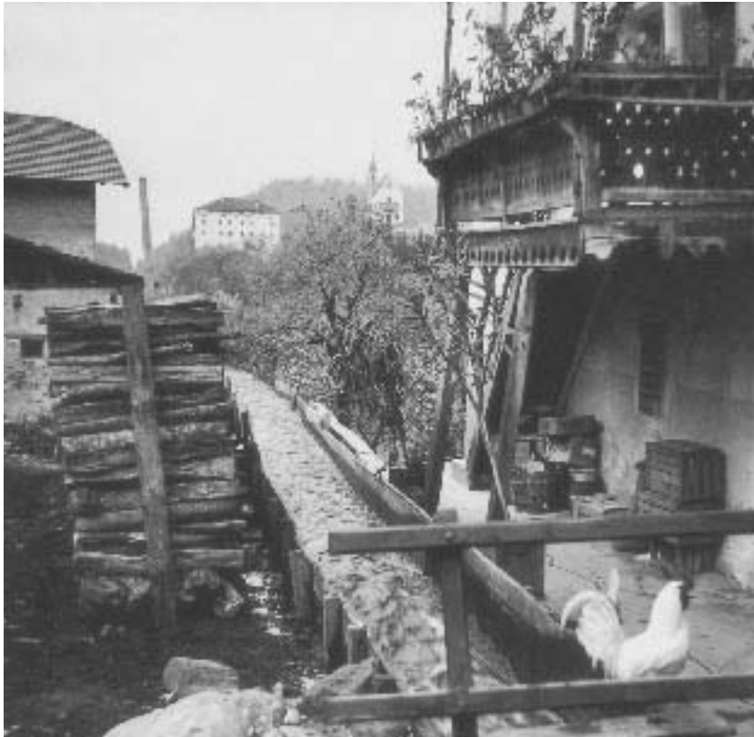
Prissians Lebensader, die „Wier“, unterhalb des Dorfplatzes. Der Kanal versorgte das Dorfzentrum und seine Handwerksbetriebe bis zur Errichtung der Trinkwasserleitung im Jahr 1957 mit Wasser.
