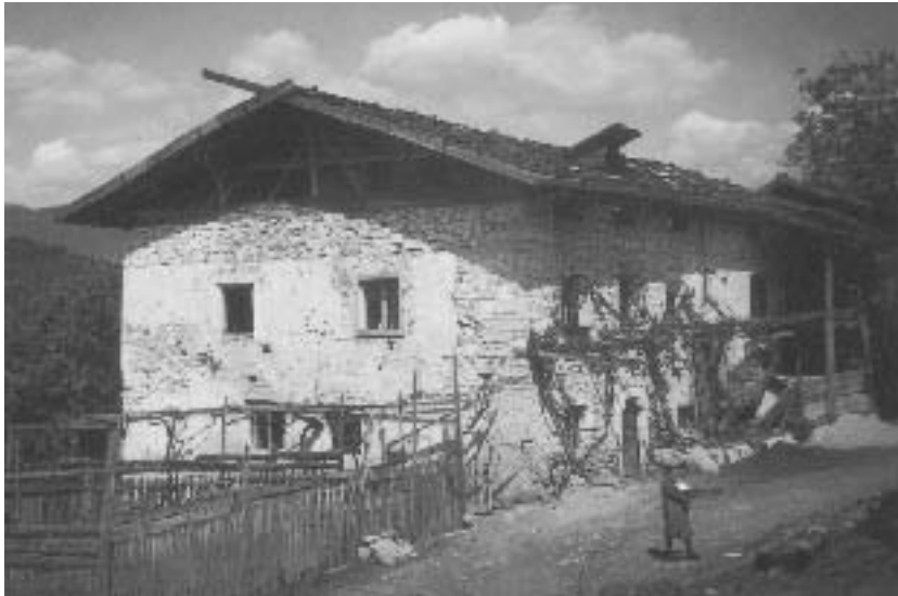
Das Haus Jakob Windeggers nahe dem Prissianer Steinbogen (1941). Auch hier werden typische Elemente traditioneller Baukultur sichtbar: Steinmauern, Schindeldach, der von einem Holzzaun umsäumte Garten. Ebenfalls charakteristisch: der Rebstock vor dem Hauseingang.
